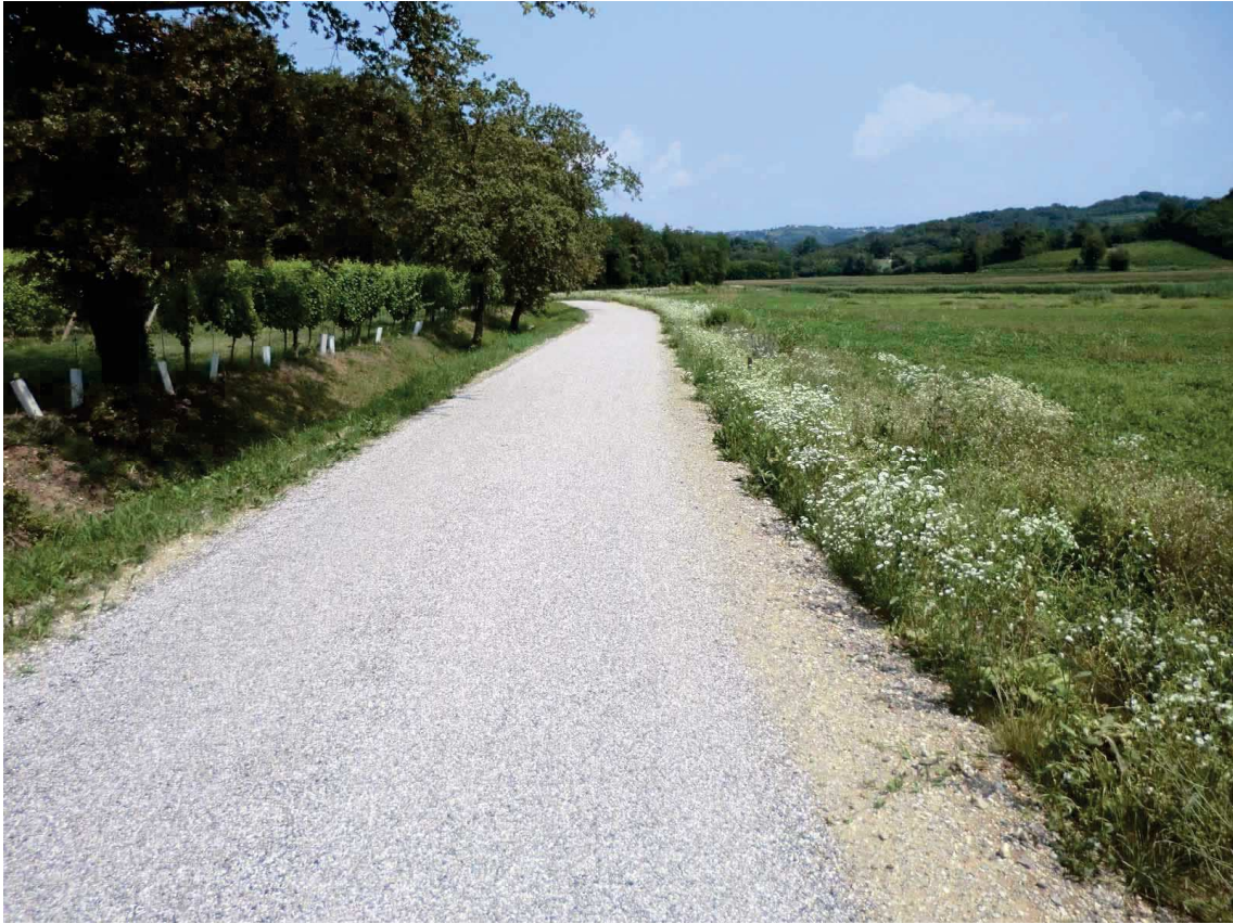
Immagine – Percorso ciclopedonale nel Collio realizzato con pavimentazione in slurry.
