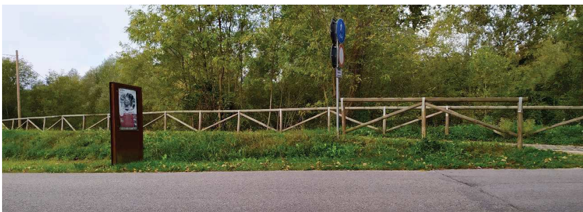
Immagine – Parapetto in legno lungo il torrente Versa all'estremo dell'it. ciclabile del Versa.
