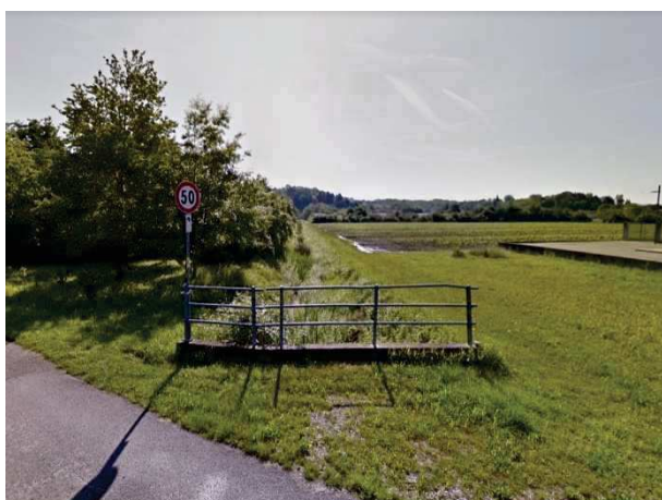
Immagine – Canale 21 (vista da via Preval).
