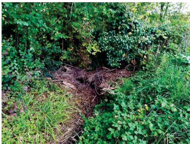
Immagine – Ponte agricolo sul rio Blacis, imbocco a monte.
