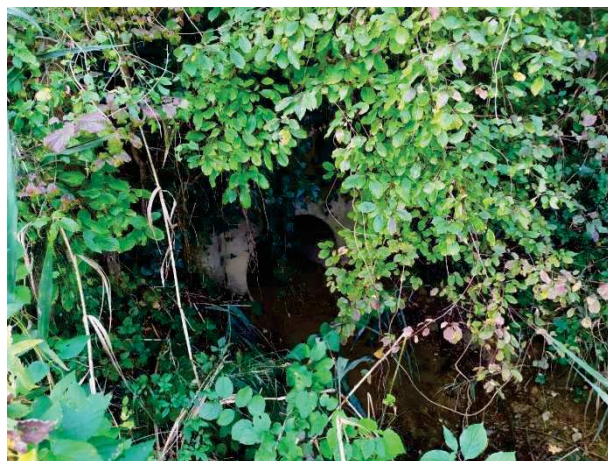
Immagine – Ponte agricolo sul rio Blacis, imbocco a valle.
