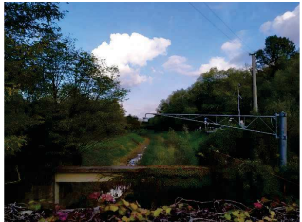
Immagine – Torrente Versa (vista verso est dal ponte di via Preval).
