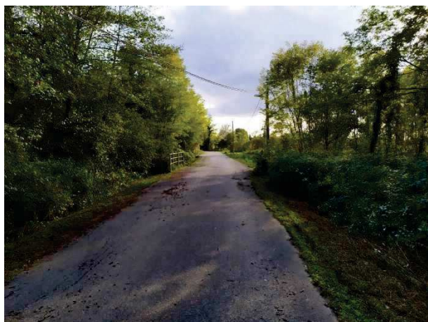
Immagine – Via Zorutti verso sud con il ponte sul rio Blacis.
